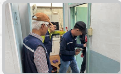
직접 자르고 조립하여 여름철 모기 막는 현관 방충망 설치!
